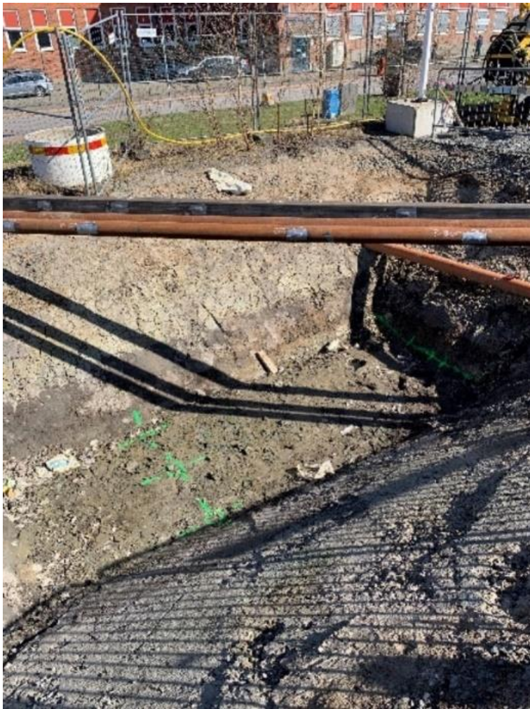
Figur 95: Installationsområde, markeringar för installation syns i schaktbotten
