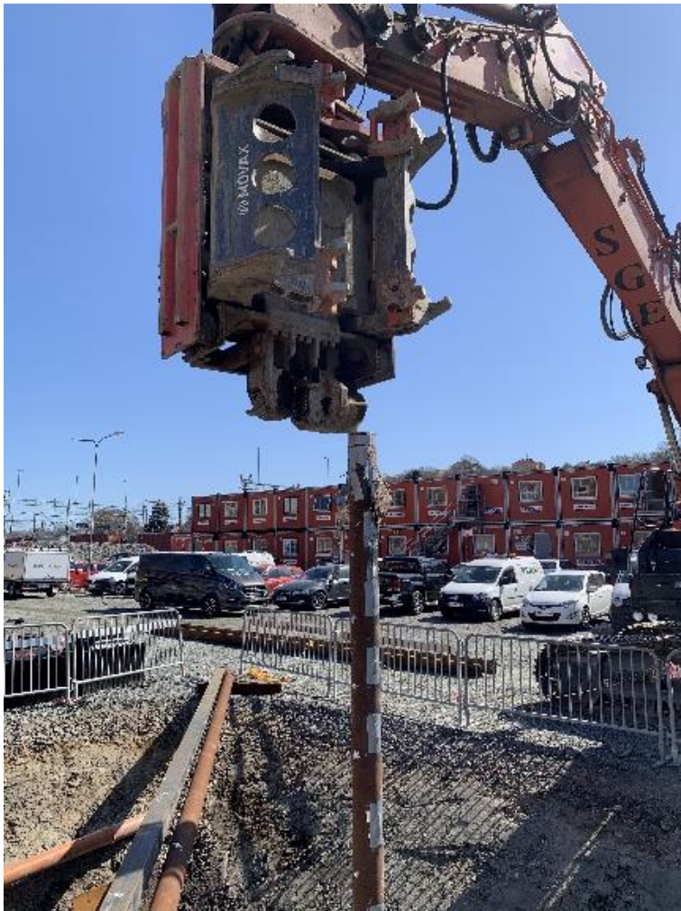
Figur 99: Djup då stålrörspålen inte kunde drivas vidare utan vibrering
