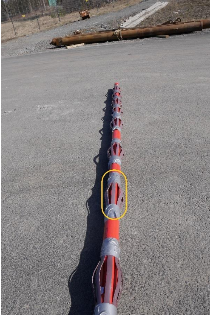
Figur 86: Distanser runt inklinometerröret
