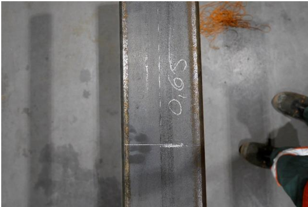
Figur 68: Färdig markering med centrumlinje och vinkelrät markering för VKR-pålen
