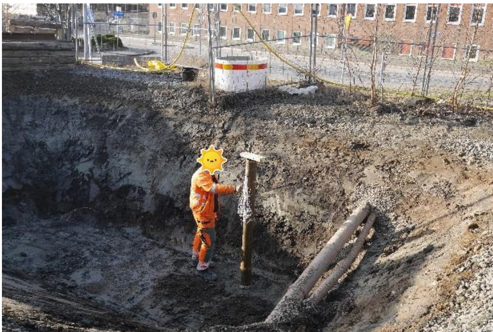
Figur 80: Installerad provpåle med töjningsgivare i lera
