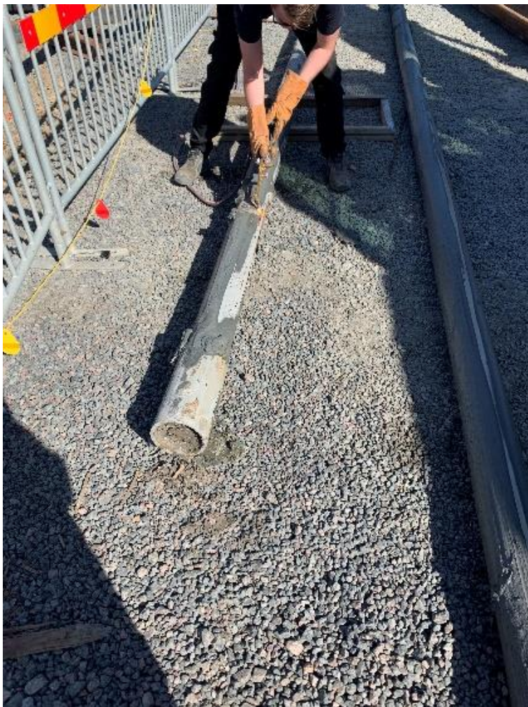
Figur 101: Kapning av pålfot med gasbrännare
