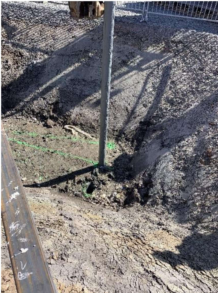
Figur 100: Prylningsarbete med tom stålörspåle
