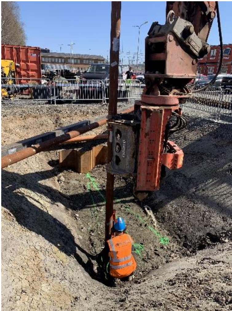
Figur 98: Kontroll så stålrörspålen installerades lodrätt samt så töjningsgivare vinklas korrekt
