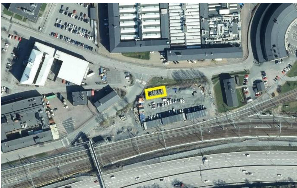
Figur 34: Överblick av område för installerade plåtar, ungefärlig uppschaktad yta är markerat med gult
