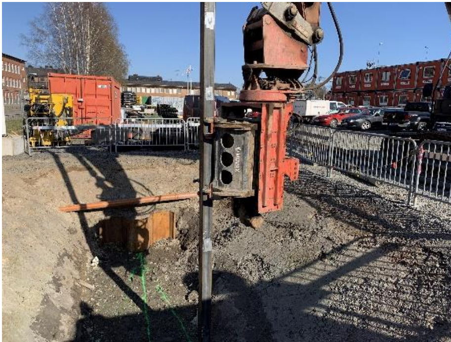
Figur 102: Installation av VKR-påle
