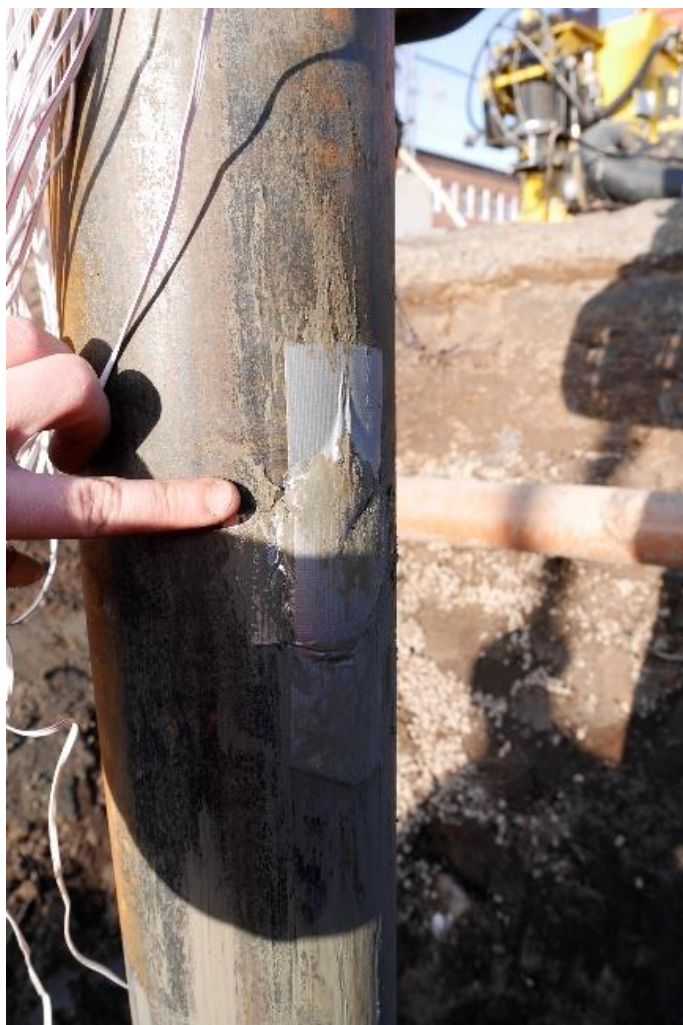
Figur 81: Visuell inspektion av givare efter uppdragning av provpåle
