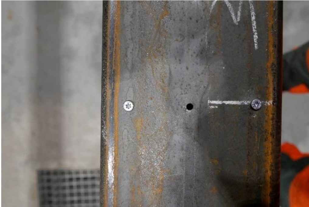
Figur 83: Fastskruvad trädistsans, i bilden ses även det centrerade hål som gjorts i VKR-pålen
