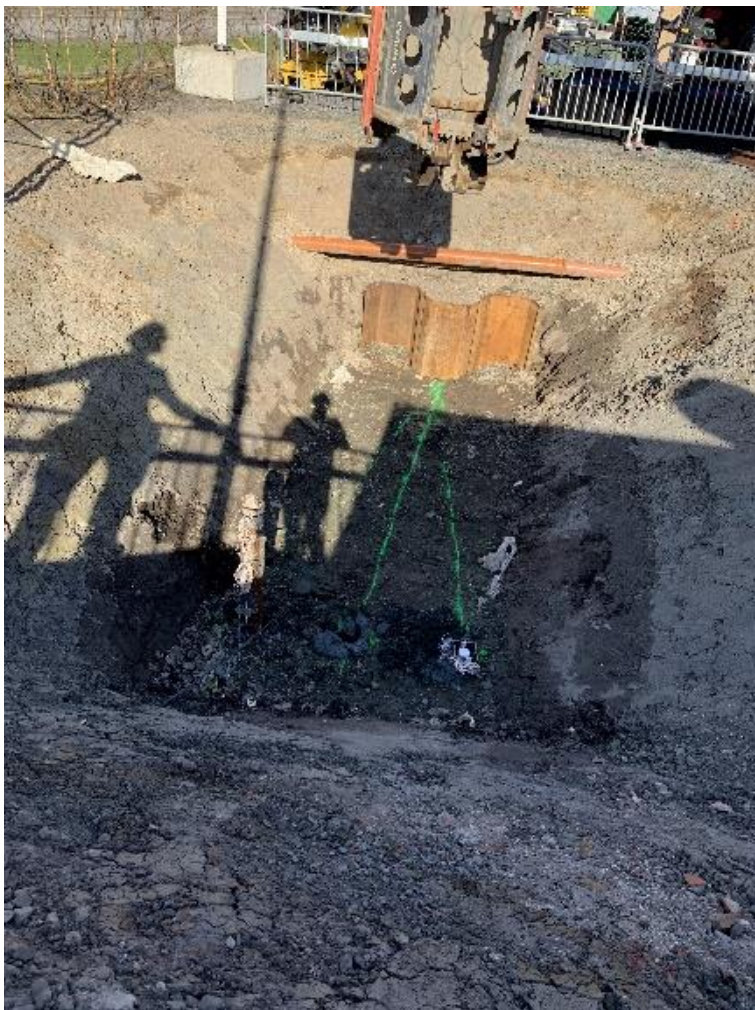
Figur 103: Samtliga stålörspålar är installerade
