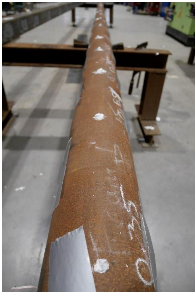
Figur 89: Nygjorda hål fylls med fogskum i de cirkulära stålörspåarna
